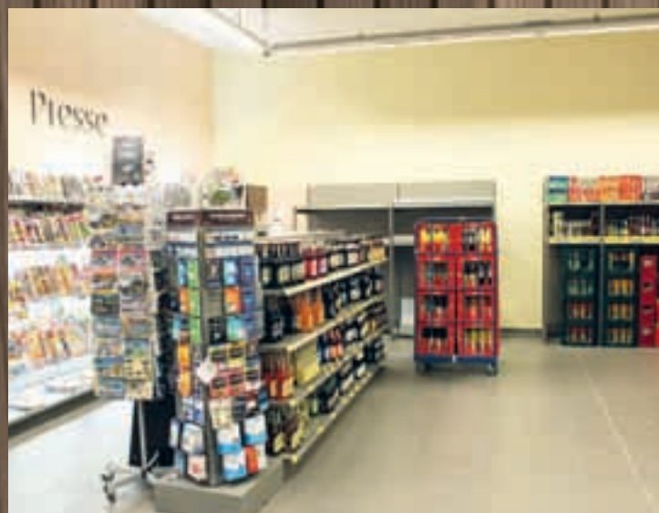
Im Presse- und Getränkeeck entsteht ein neues Kassenbüro
