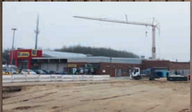
EDEKA Jens im Umbau – im April sollen die Arbeiten abgeschlossen sein
