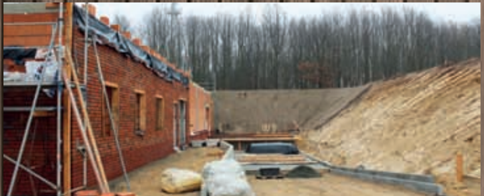
Hier entsteht die weitere Laderampe
